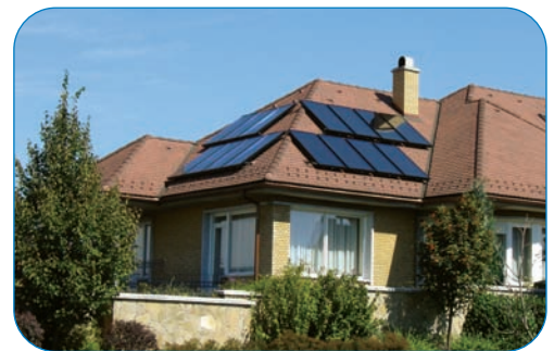
Családiház 2 irányú síkkollektor rendszer Somogy megye
